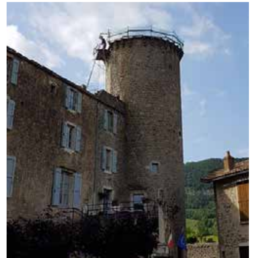
La Tour Garnier en rénovation
